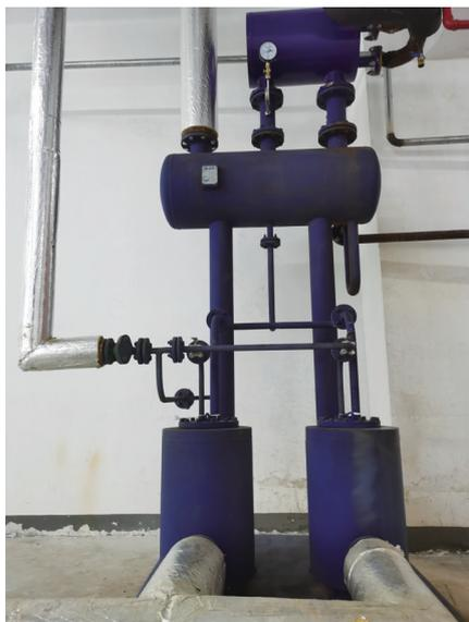
圖：冷凝水回收系統
